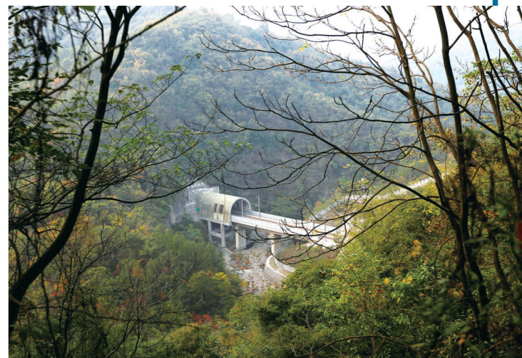
从剑河水库下游跨过剑河的汉十高铁铁路。
