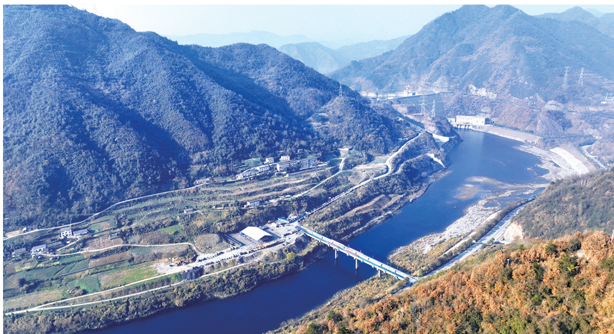
2022年12月24日,总投资26.83亿元的潘口抽水蓄能电站正式开工。
