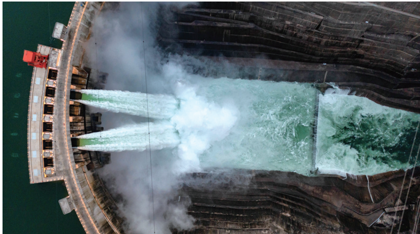
白鹤滩水电站一景。
