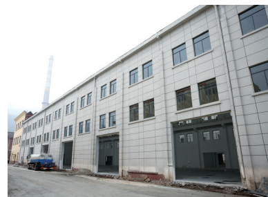
改造后的老厂房焕然一新。
