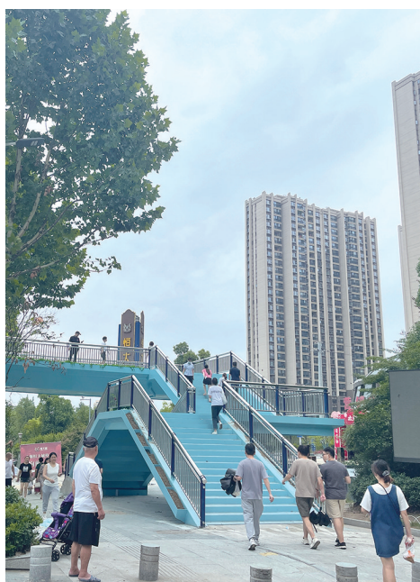
上海路人行天桥上,行人必须爬上较高的楼梯,才能走到马路对面。
