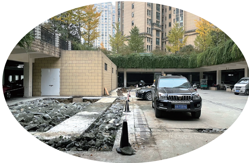
目前,和昌国际城二期小区电网改造项目暂时停工。
