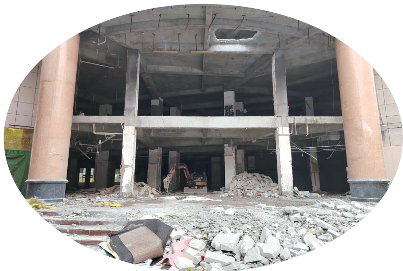
商舖的地砖、吊頂已基本全部拆除,地面上堆積了不少打掉的磚塊。
