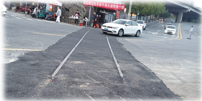
废弃的铁路轨道被填平,周围路面进行了硬化。
