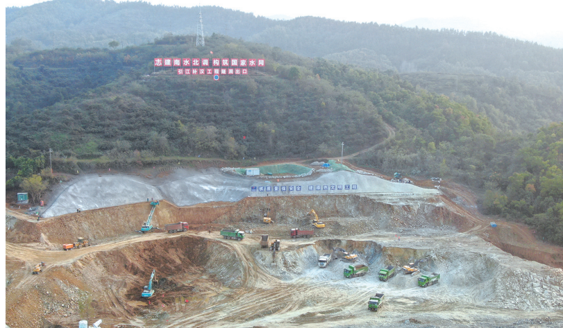
施工现场,挖掘机、运输车忙个不停,建设者加紧施工。
