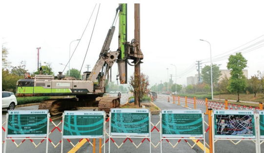
采用旋挖钻机施工缩短了施工时间。
