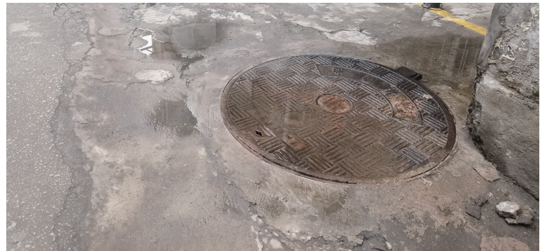
下水管道疏通后,再也没有污水往外流了。
