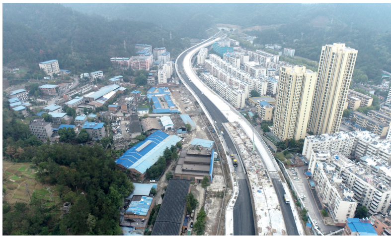
艳湖高架桥正在加紧施工。
