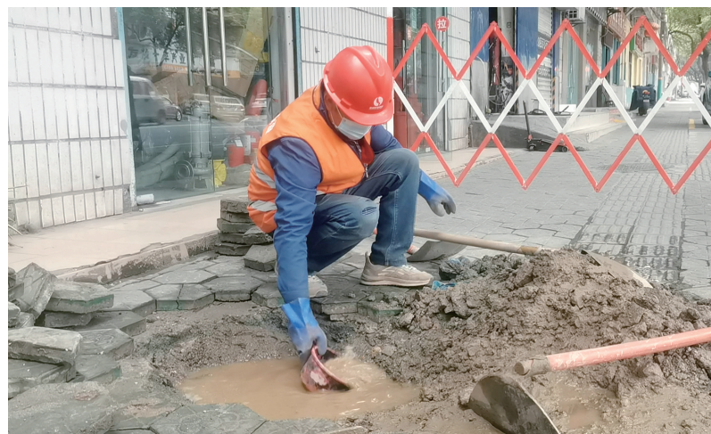
施工人员正在现场维修。
