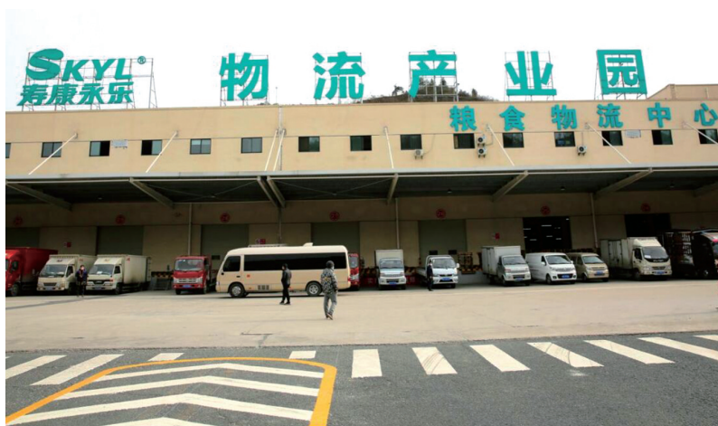
位于郧阳区茶店镇长岭的寿康永乐物流产业园占地面积300亩,总投资5亿元。
