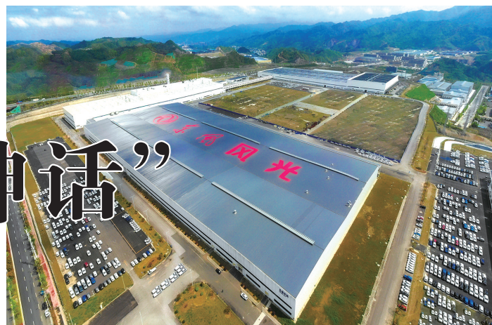
东风小康十堰空港工厂位于十堰经开区空港产业园,占地2008亩。
