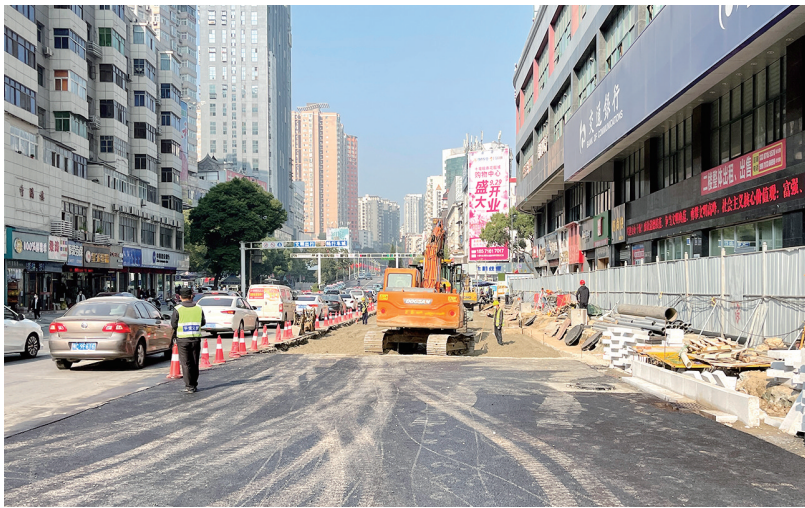
工人们正在进行收尾工作。
