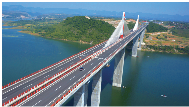
鄖阳区境内,鄖十高速横跨碧波荡漾的汉江。
