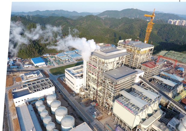
2018年10月,相关设备安装完毕并进行调试。
