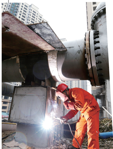
2018年12月,京能十堰热电与我市原有的供热管网贯通合龙。
