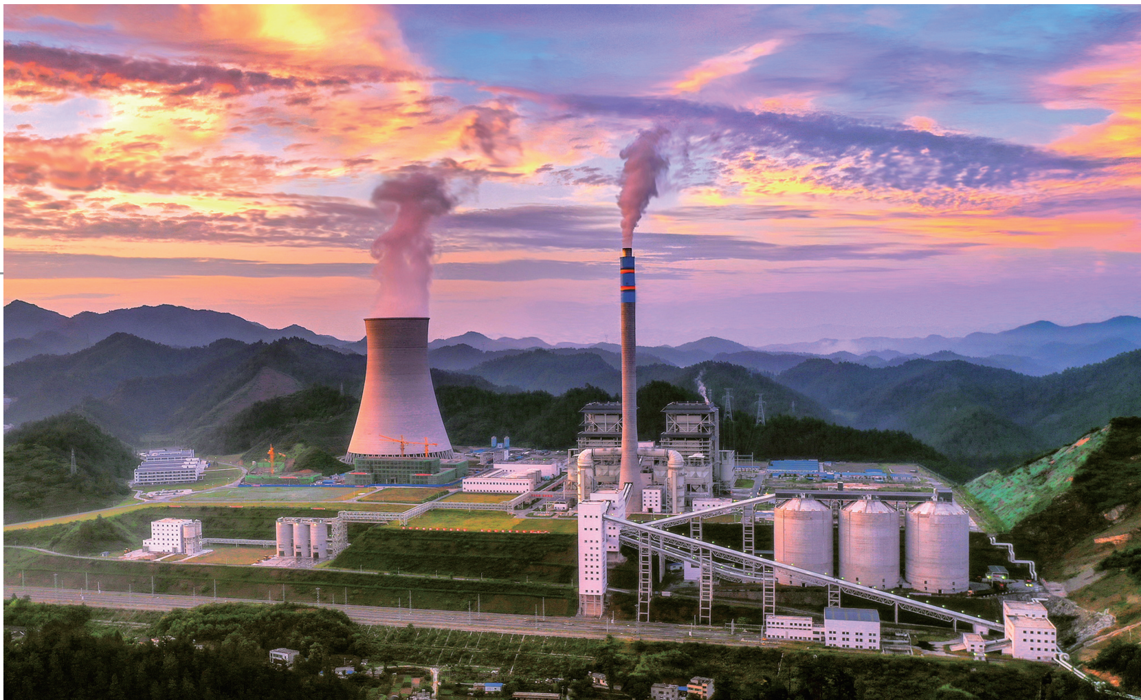
京能十堰热电联产项目是我市“十三五”重大民生基础设施建设项目。
