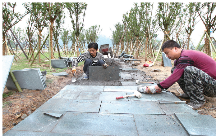
2014年,工人在四方山铺设游步道。
