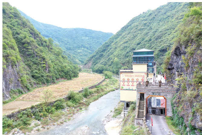
村前碧水翠岸、桥梁流水、栈道濒河、亭榭掩映。
