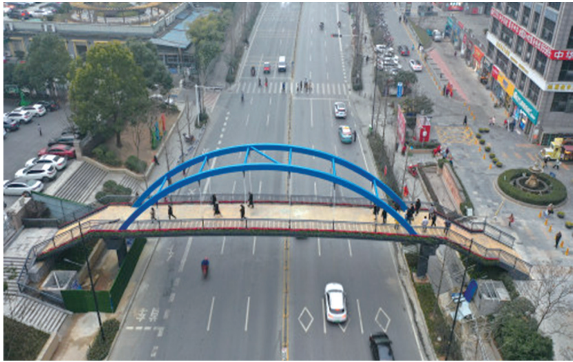
今年1月20日,阳光栖谷过街天桥正式通行。(资料图片)
