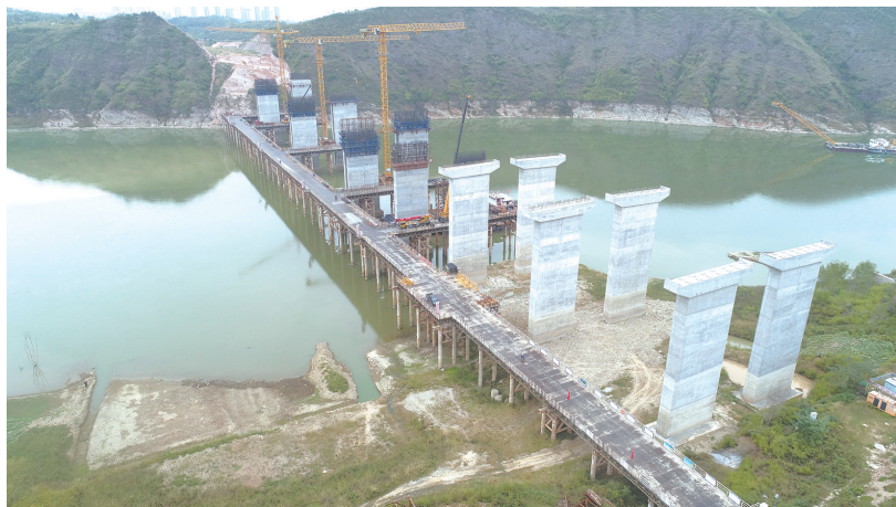
神定河大桥水中墩全部出水,圆满完成年度目标。
