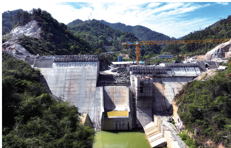
朱家咀水库大坝主体基座和中段基本成型。
