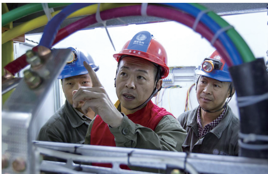
冯良盛在检查配电设备。
