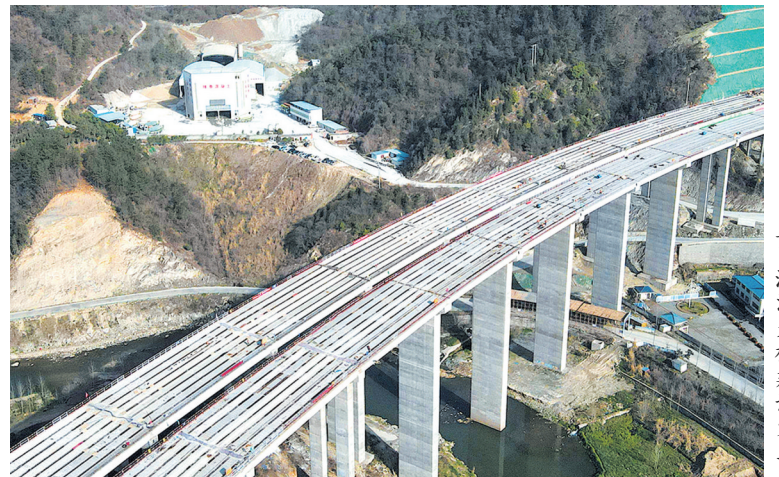
目前,泗河大桥建设完工。
