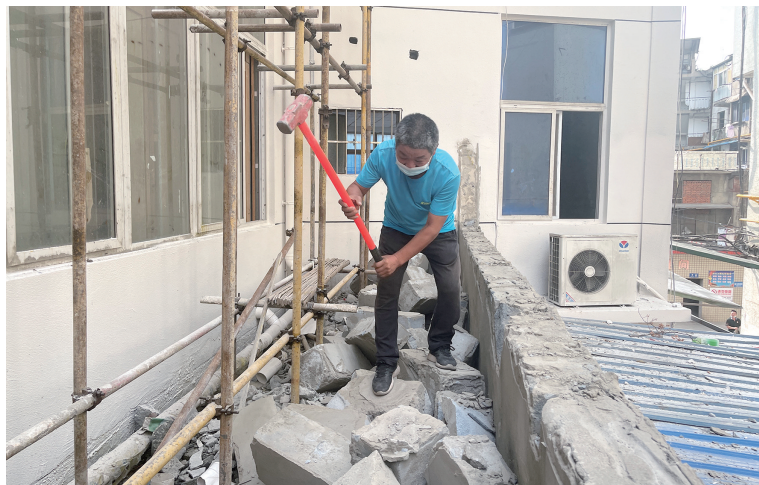
工作人员对该处违法建筑进行强制拆除。
