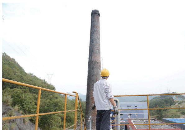
医疗废物焚烧烟气经过脱酸、消除二噁英等一系列处理达标后,才能通过45米高的烟囱排放。
