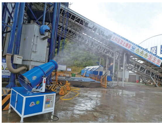
使用环保雾炮机对混凝土搅拌站实施降尘处理,确保不影响水库环境。
