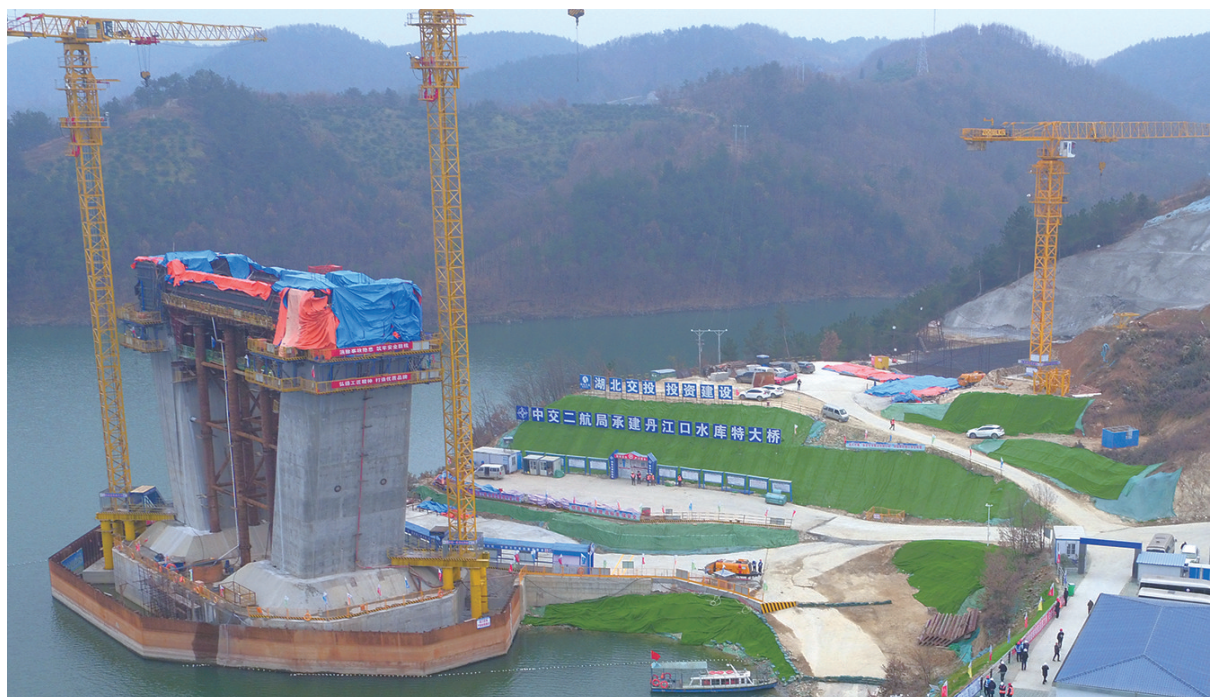
在丹江口水库特大桥施工现场的裸露边坡上,全部苫盖着绿色防护网。
