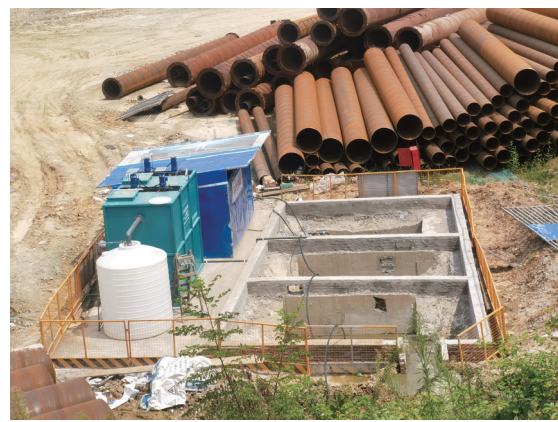
在建筑工人居住的生活区装置油水分离器,每天的厨余废水都要在这里进行初步处理。
