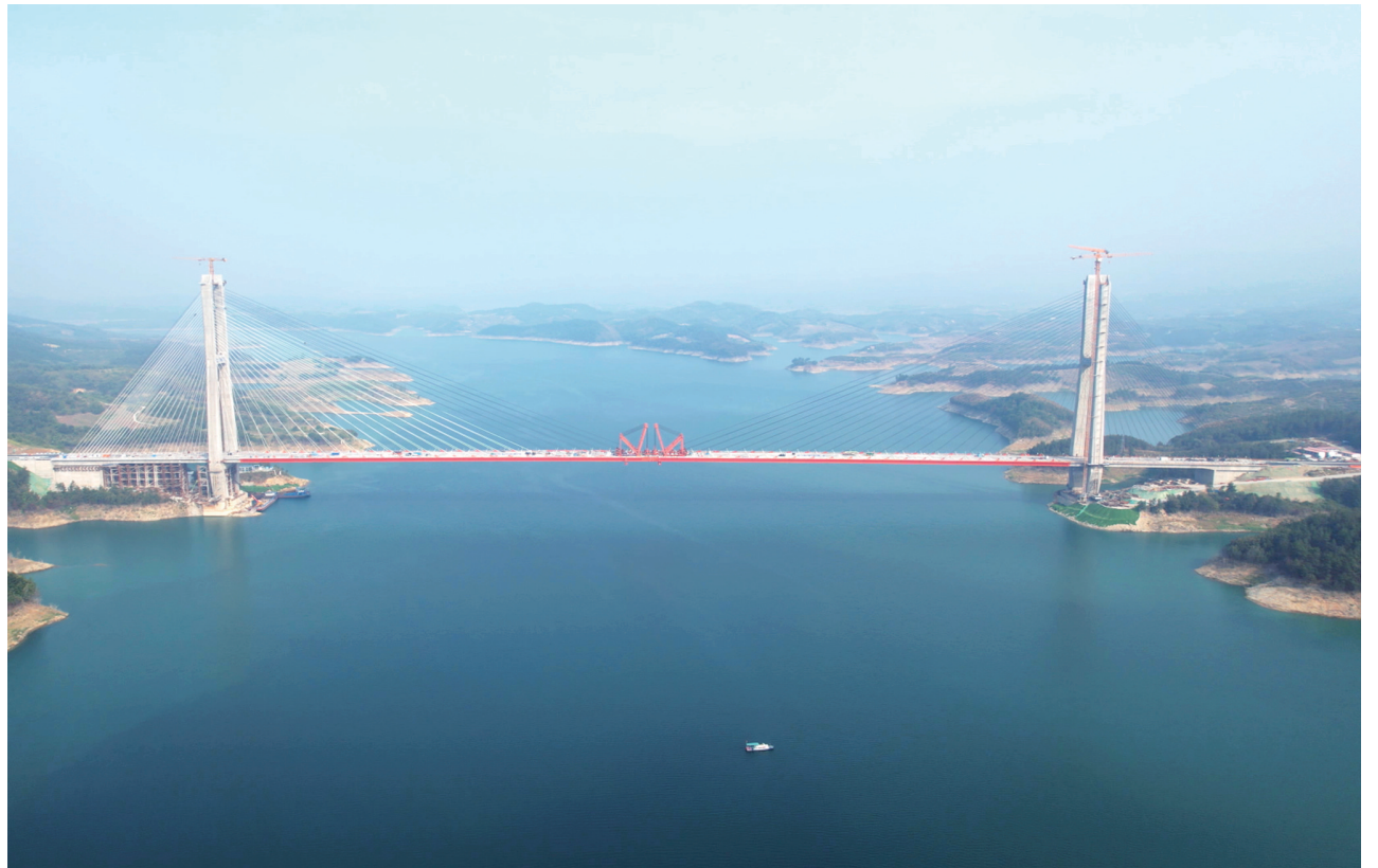
全长1076米,主跨达760米的丹江口水库特大桥是十浙高速重点控制性工程。
