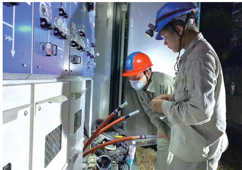
冯良盛(左)和同事抢修电力故障。
