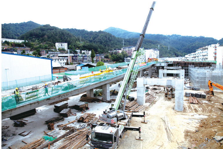
在武当路复线和三峡路PPP项目施工现场,工作人员正在赶进度、抢工期。
