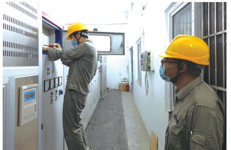
施工人员对小区电力进行改造。
