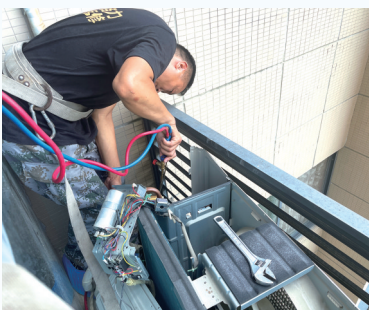
胡女士家的空调外机四通阀内部损坏,维修人员帮忙处理。
