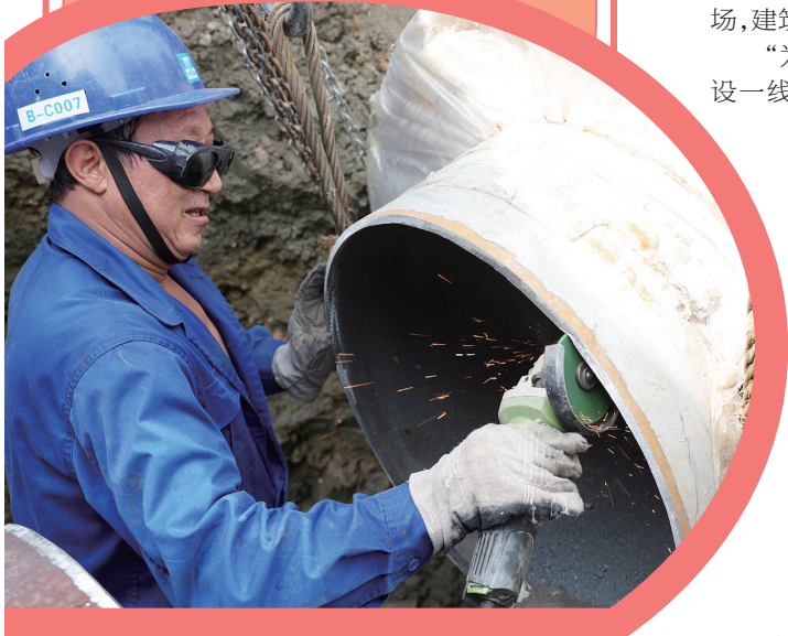
建筑工人们冒着酷暑坚守在建设一线。 图/记者 张启国
