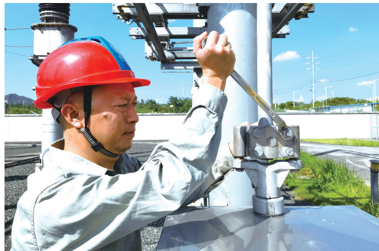
李明辉在安装变电设备。
