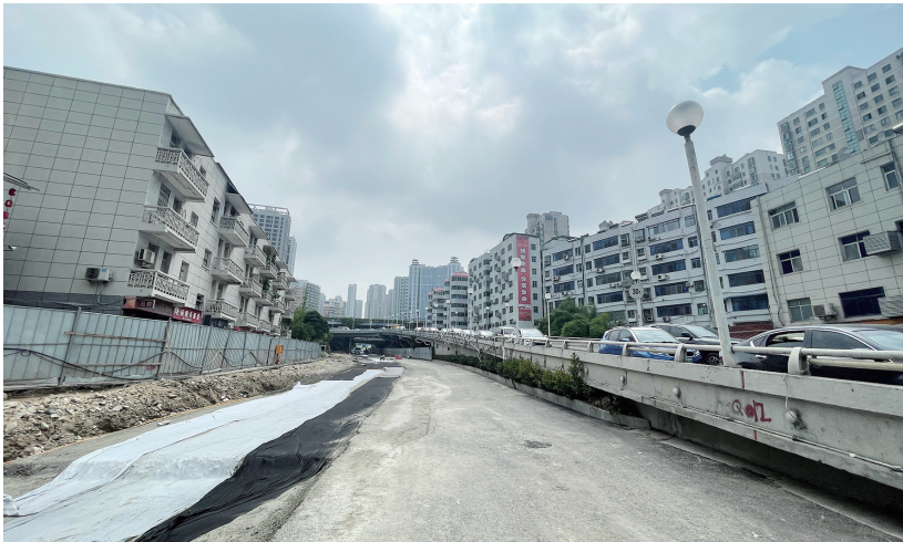
柳林路部分路段正进行路面回填。
