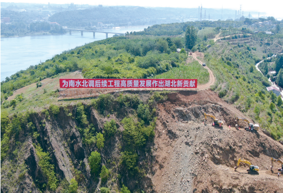
南水北调后续工程中线引江补汉工程开工现场。
