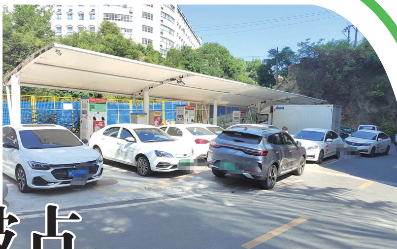
在北京南路一处公共充电站,一辆燃油车(左)占用充电车位,旁边一辆“绿牌”车停在路边等候。
