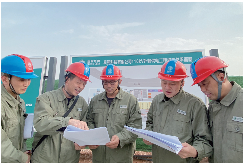
提前现场勘查,制作施工方案。
