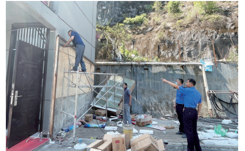
第一处违建主体房屋拆除前后。
