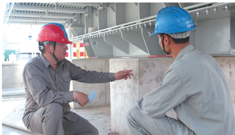
涂锐平(左)在检查设备基础。
