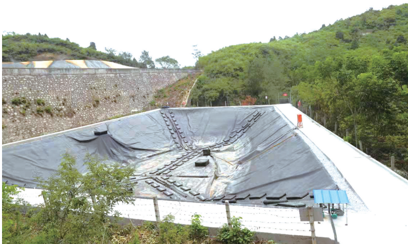
渗滤液收集池被“锅盖”覆盖。
