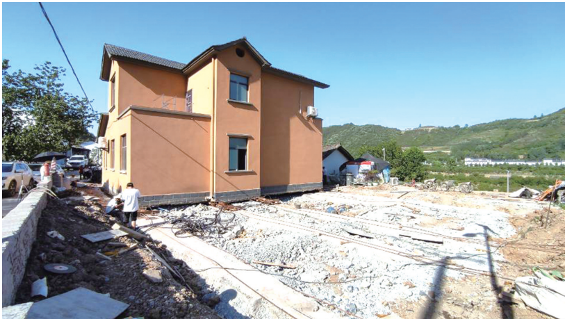
经过11个小时的紧张施工,房屋安全平移14米。
