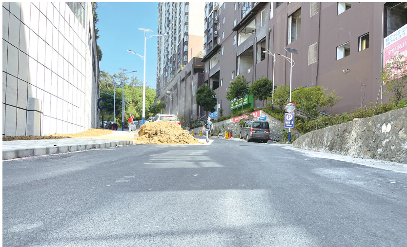
改造后的长青巷道路平整,并增设了人行道。
