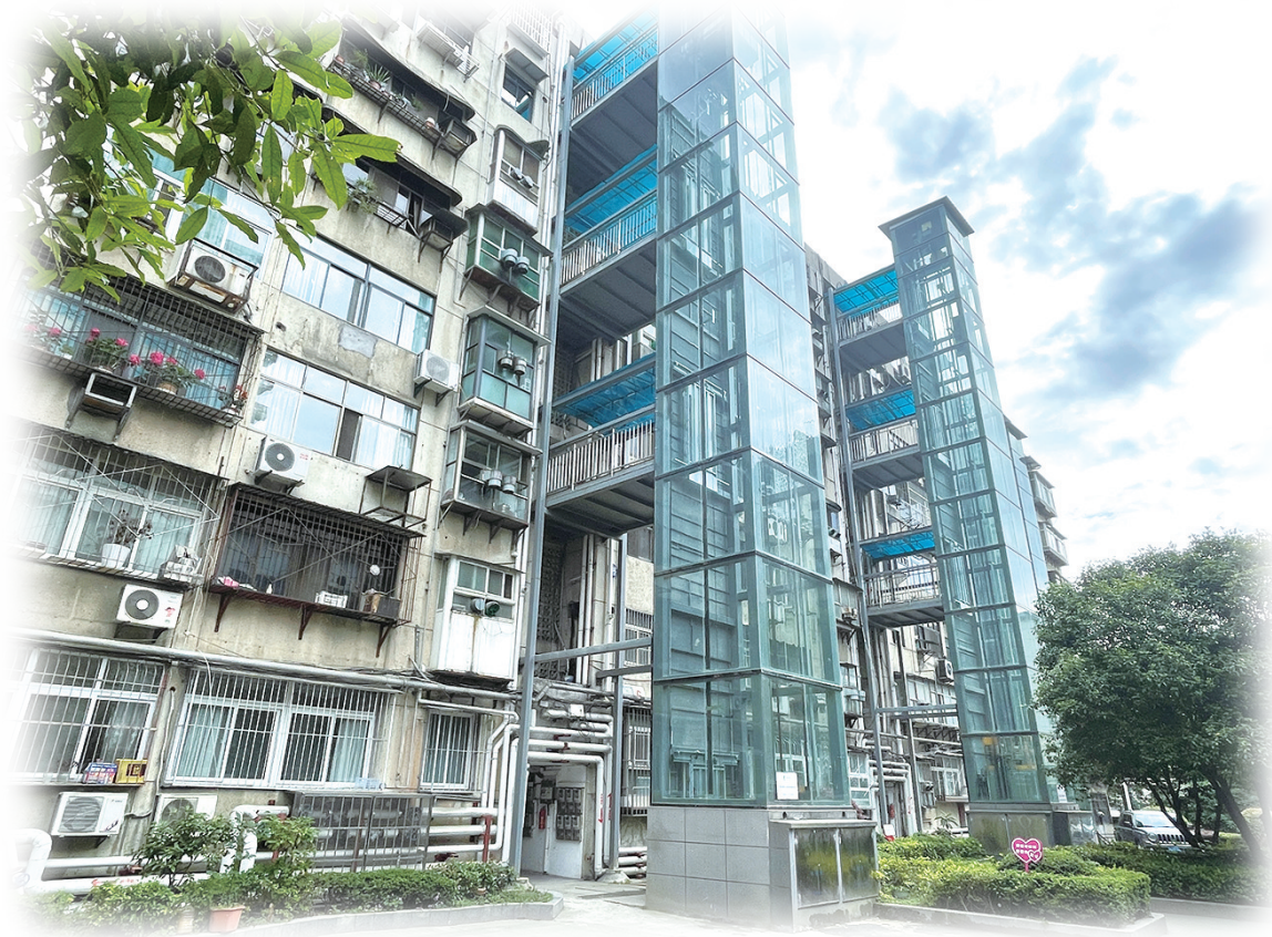
我市一老旧小区安装的电梯。
