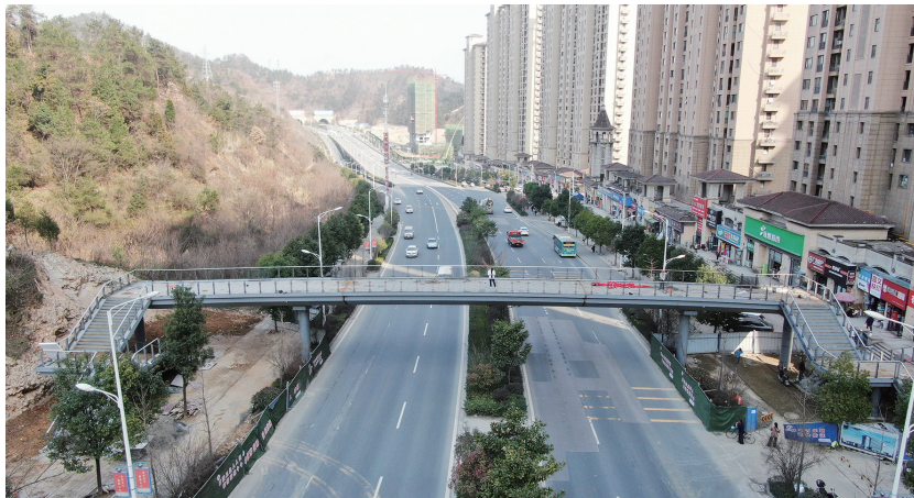
林荫大道二号线过街天桥已完成主体施工。
