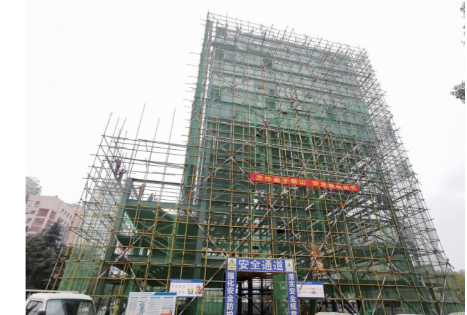
六堰立体停车场目前已完成框架搭建、防锈漆喷绘等工作,今年上半年将投入使用。张启国/摄
