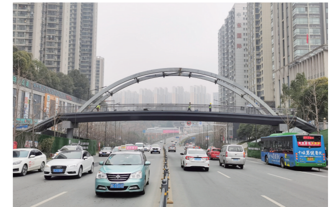
北京北路两座人行天桥正在施工中,春节前将投入使用。张启国/摄
