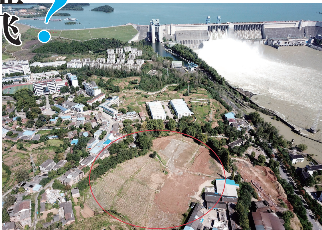
武当云谷大数据中心土建工程已动工(画圈处)。
