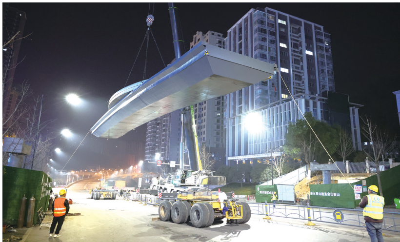
昨晚,阳光栖谷过街天桥主跨钢箱梁进行吊装。
