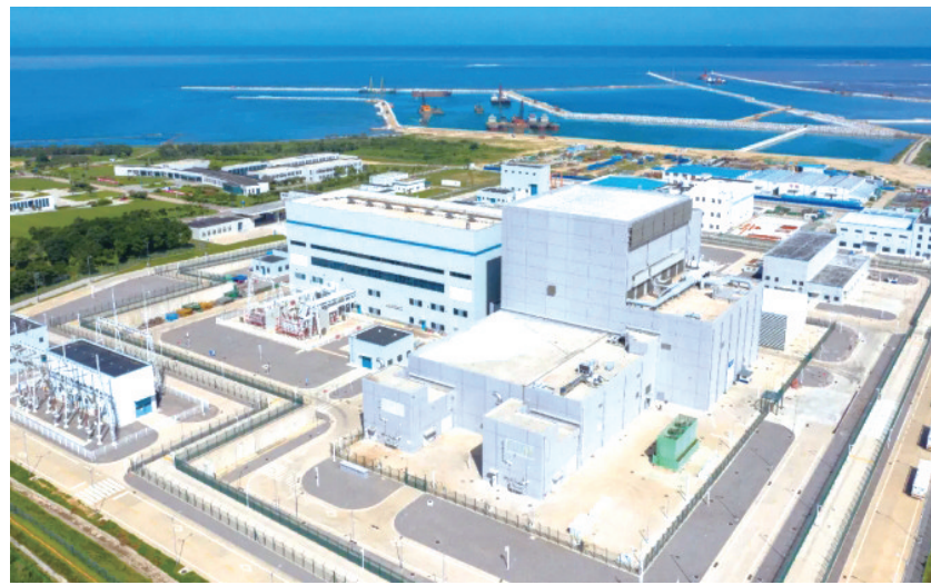
位于山东荣成石岛湾的华能高温气冷堆实现并网发电。
