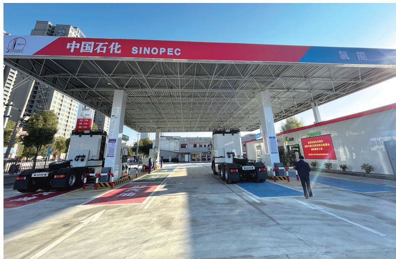
中石化十堰阳光综合能源站集加油、加氢、充电于一体。
